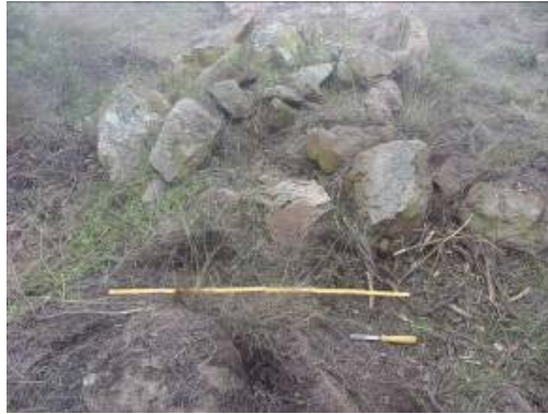
Figura 12: Detalle. Muro ladera norte, punto 3
