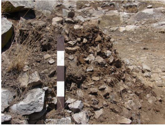
Figura N°12: Vista lateral del muro estabilizado. (Sepúlveda, 2011)
