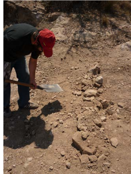
Figura Nº 17: Consolidación cárcava menor. (Lemp, 2011)
