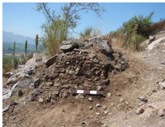
Figura N°11: Vista frontal del muro estabilizada con sección de sacrificio. (Sepúlveda, 2011)
