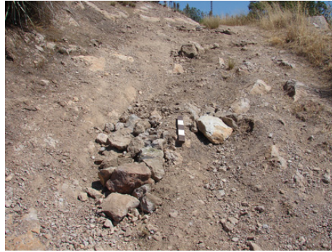
Figura N° 19: Detalle de consolidación cárcava menores.(Sepúlveda, 2011)
