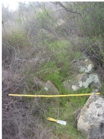
Figura 15: Detalle muro adyacente a la cuadrícula 18, punto 6. Presenta un mal estado de conservación
