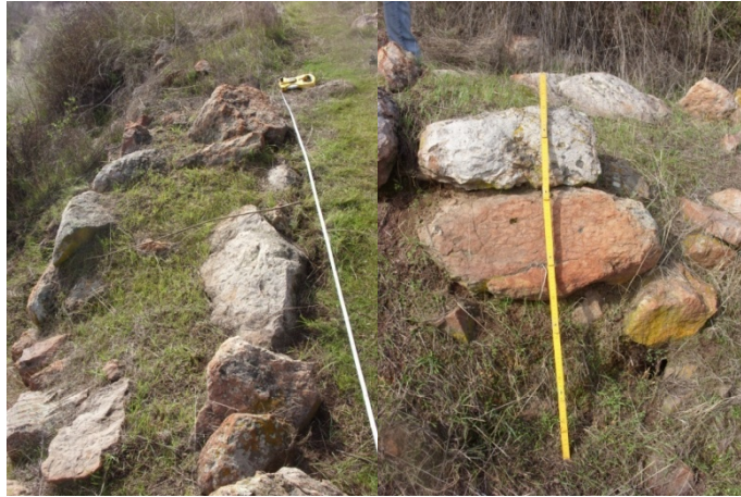
Figura 18: Muro punto 8, a) Detalle, b) Perfil muro, configuración talud en ladera
