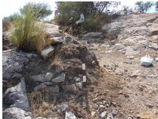
Figura Nº 5: Vista este del muro afectado. Camino en desnivel. (Sepúlveda, 2011)
