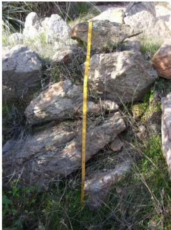
Figura 23: Detalle de inicio muro del sector destruido por el camino, punto 14.
