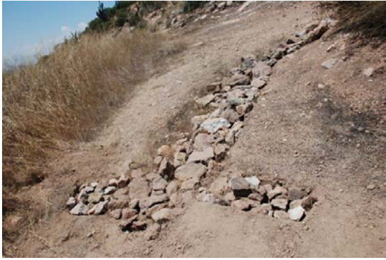
Figura Nº 14: Consolidación de cárcava mayor en forma de T, sección inferior (Troncoso, 2011)
