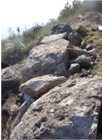
Figura 22: Detalle muro con rocas de gran tamaño, punto 13.
