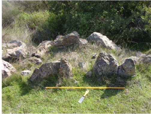
Figura 24: Detalle muro, punto 15.
