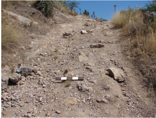
Figura N° 18: vista general consolidación cárcavas menores. (Sepúlveda, 2011)
