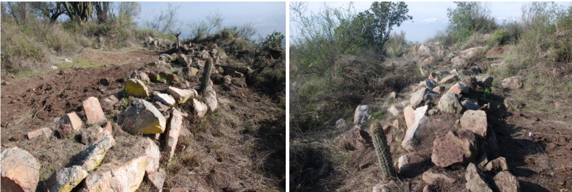
Figura 8: Vista del muro perimetral en ladera Oeste y sector Norte
