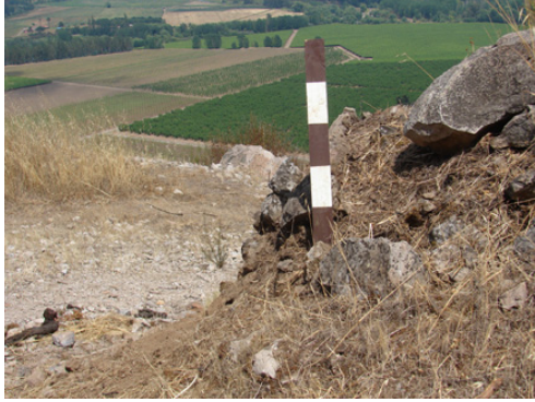
Figura N°6: Vista oeste del muro afectado. (Sepúlveda, 2011)
